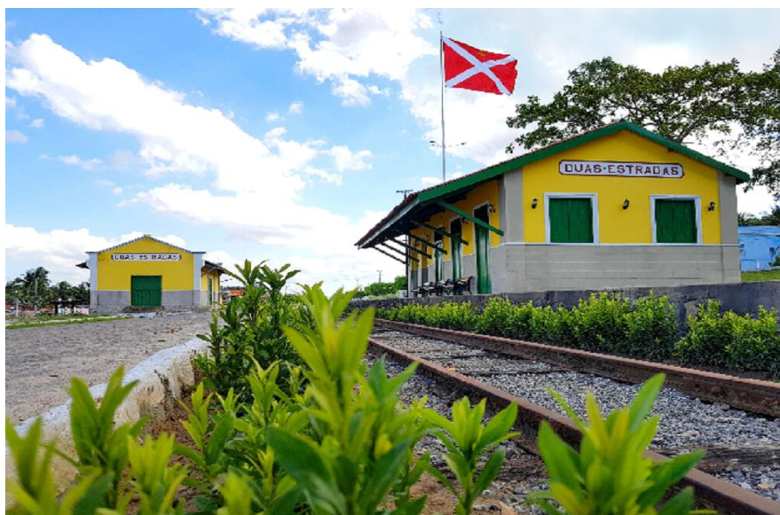
Figura 8 - Estação Ferroviária após a revitalização
