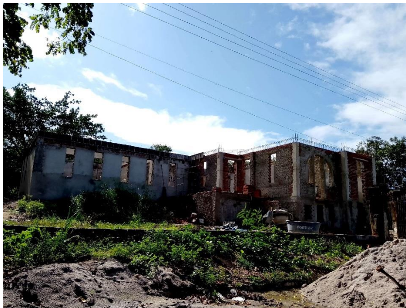
Figura 14 - Palacete em construção
