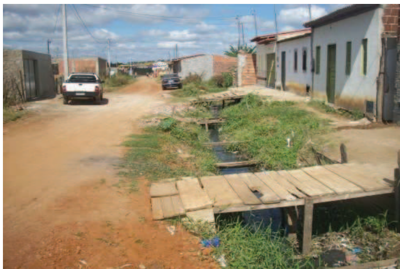
Figura 5: Déficit na infraestrutura urbana
