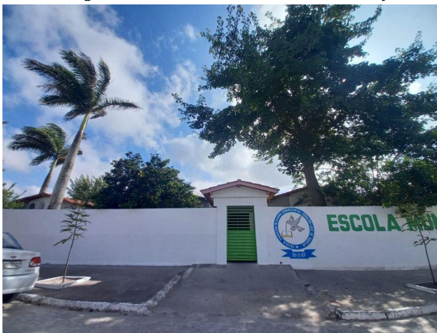
Figura 1: Prédio da Escola Geraldo Luiz de Araújo
