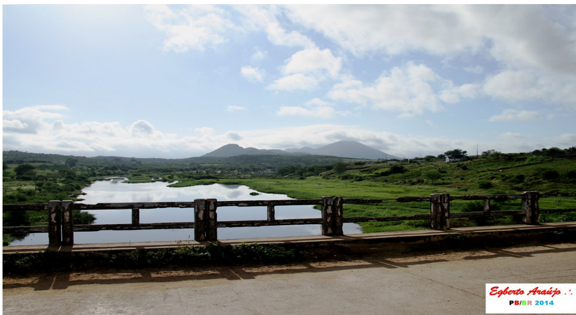
Figura 9 - Vista da ponte sobre o Rio Paraíba em Boqueirão - PB
