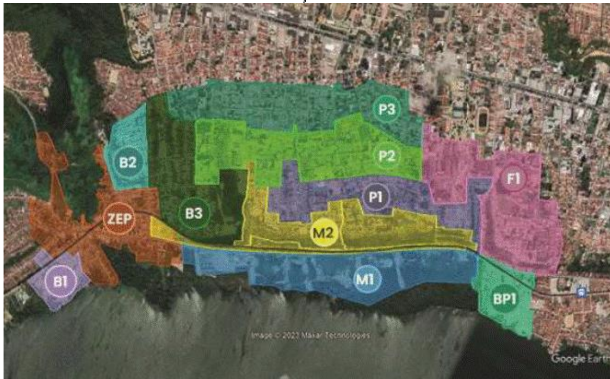
Figura 3 - Área de demolição nos bairros com afundamento de solo em Maceió foi dividida em 11 setores Localização das áreas diretamente afetadas
