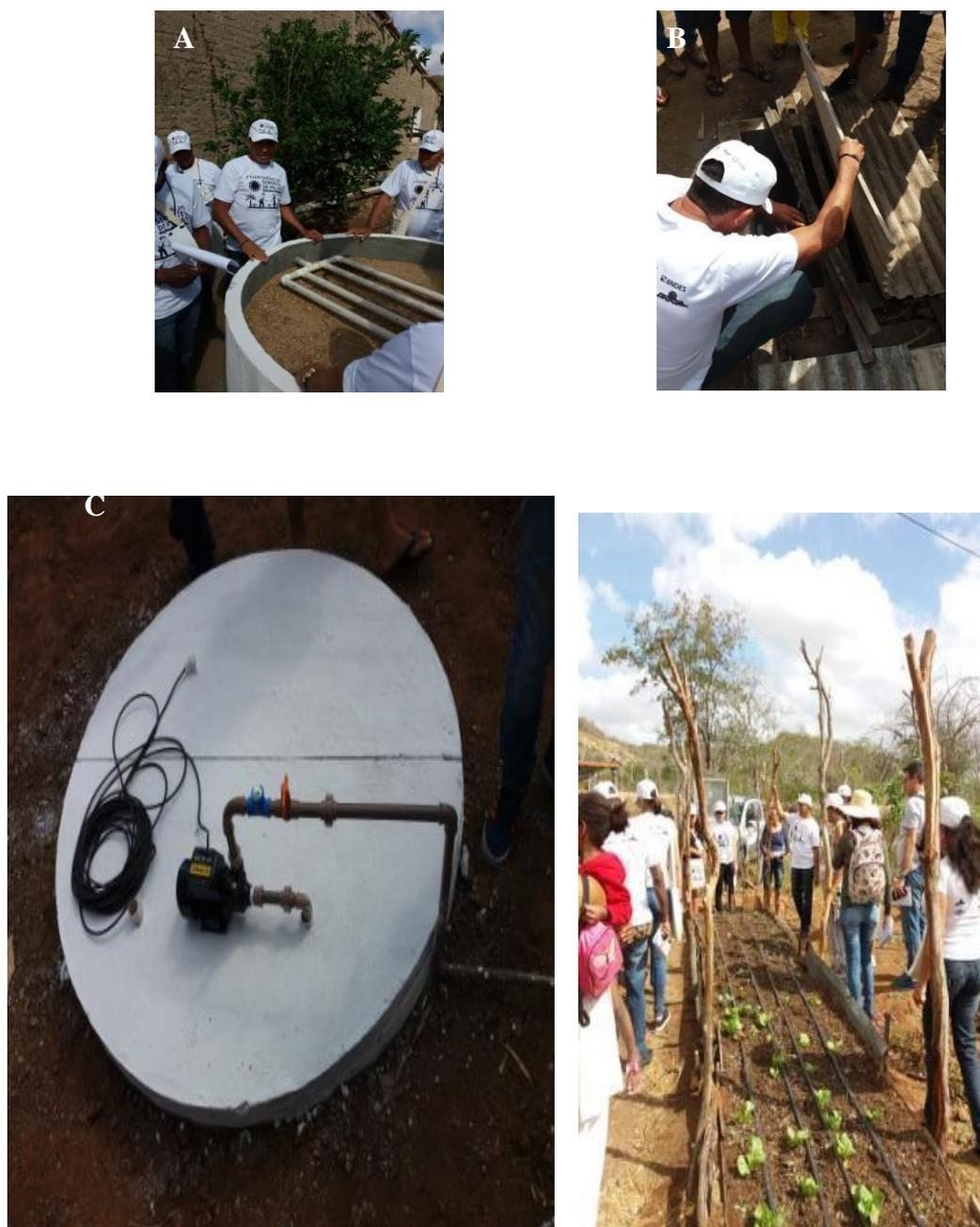
**Figura 2.** Sistema de Reuso de água com sistema de irrigação simplificado, com filtro para água cinza (A), filtro anaeróbico(B), poço com bomba hidráulica (C) para alimentar o sistema de irrigação (D).
