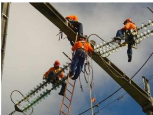
Figura 10 – Trabalho de eletricistas em 230kv em Estrutura concreto - Fonte: Arquivo Eletrobrás
