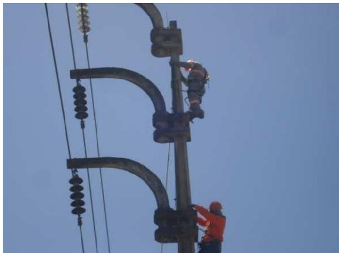
Figura 9 – Eletricistas escalando linha de transmissão em estrutura de concreto – Fonte: Arquivo Eletrobrás
