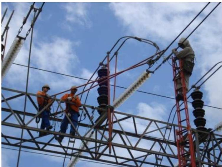
Figura 8 – Trabalho Energizado em Subestação 230kv -
