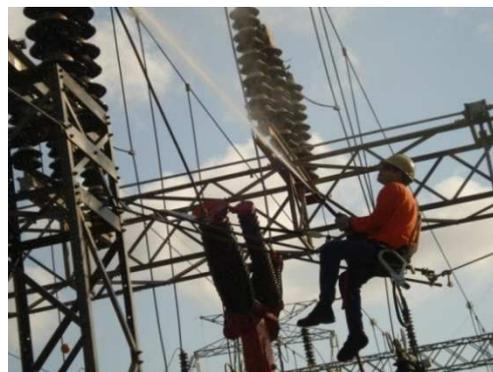
Figura 11 – Lavagem de isoladores poluídos SE 230Kv Energizada – Fonte: Arquivo
