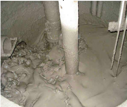
FIGURA 4- Tanque de bombeamento da lama abrasiva
