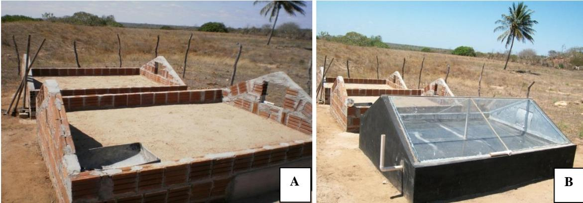
Figura 5: A – B. Vista panorâmica do Destilador Solar em fase de construção no sítio Lagoa da Serra, Soledade /PB.
