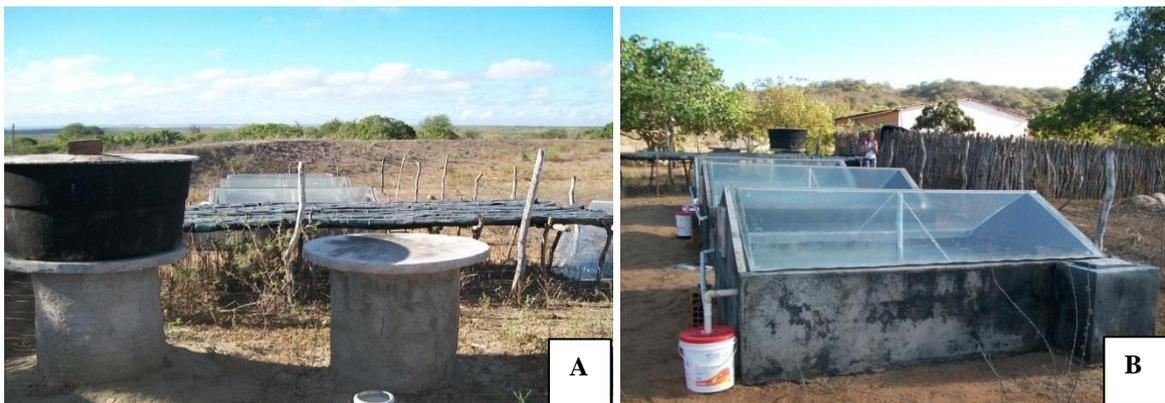
Figura 6: A – B. Sistema de Coleta de água dessalinizada no sítio Lagoa da Serra, Soledade/PB.
