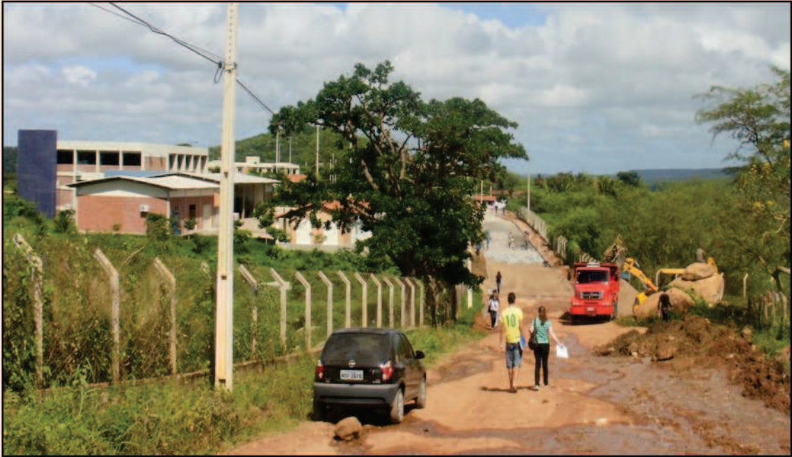
Figura 05: Obras de pavimentação do acesso ao Campus do CES-UFCG, Cuité 2011.
