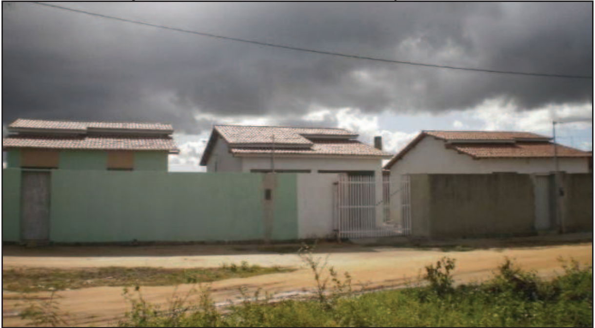
Figura 10: Condomínio habitacional em construção Cuité-PB.
