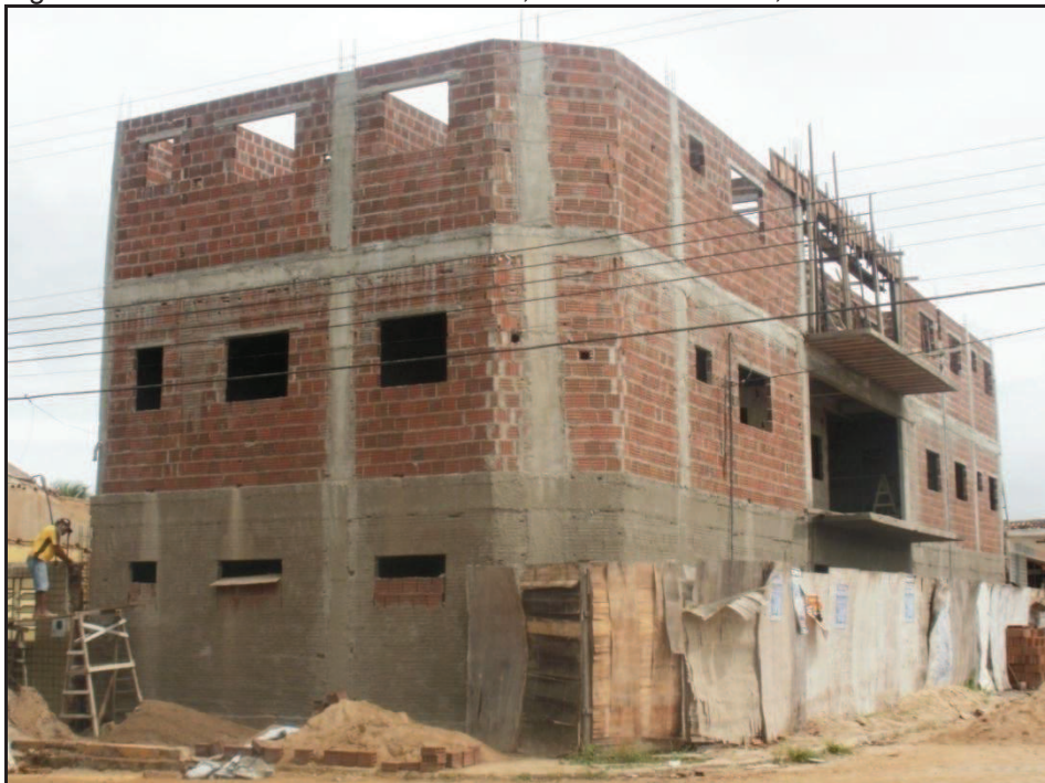
Figura 11: Edifício residencial em obras, Rua Pedro Godim, Centro de Cuité-PB.
