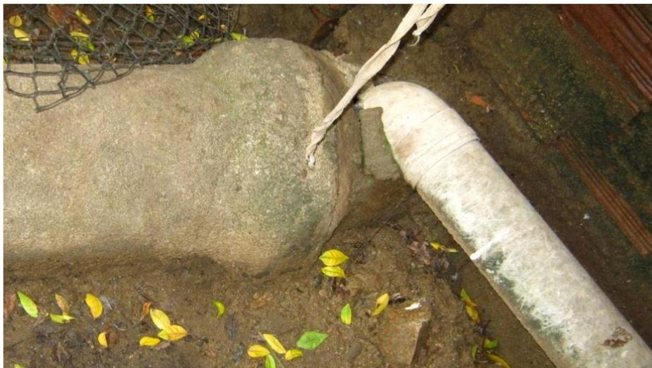
Figura 16 – Ligação do ramal interno com a rede coletora de esgoto.
