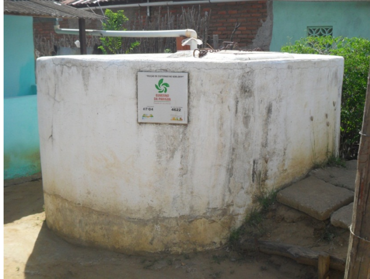
Figura 2.1 – Cisterna construída no Sítio Batente de Pedra, Ingá - PB.
