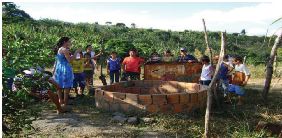
Figura 21: Poço para armazenar água no Sítio Ribeiro.
