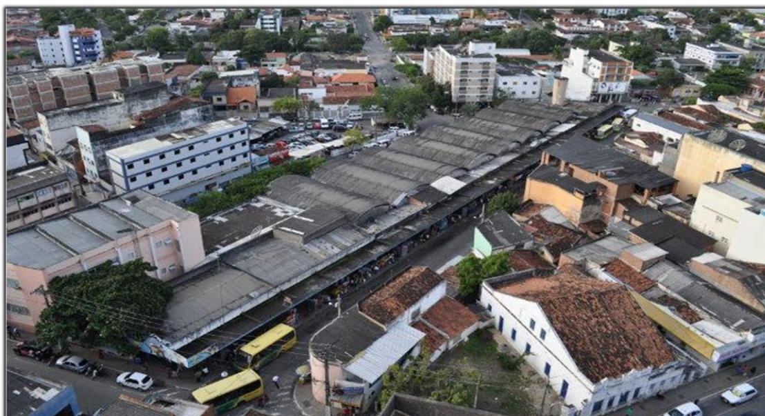
Figura 16 – Vista superior do Terminal Rodoviário Cristiano Lauritzen de Campina Grande, PB.
