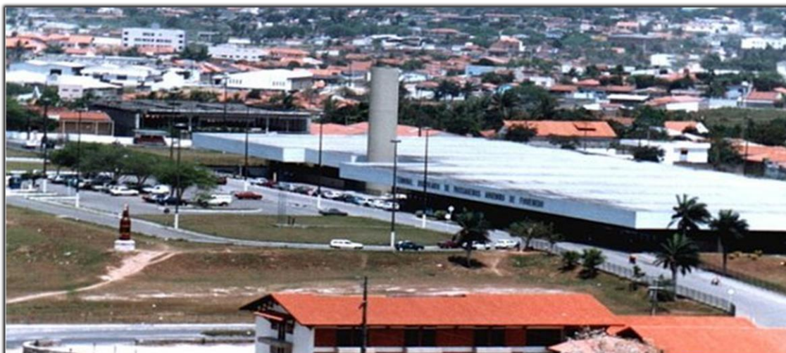
Figura 18 – Vista da fachada do Terminal Rodoviário Argemiro de Figueiredo de Campina Grande, PB.
