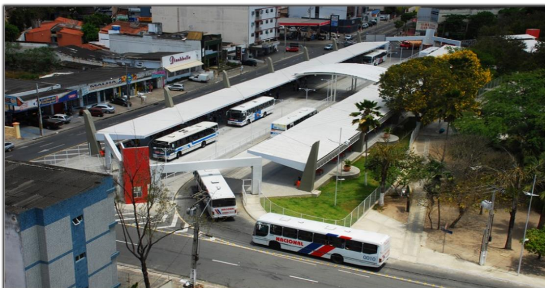
Figura 12 – Vista superior do Terminal de Integração de Passageiros de Campina Grande, PB.
