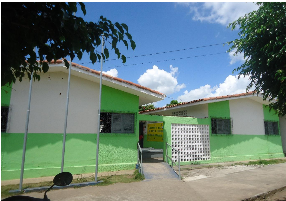
Figura 1 –Escola Municipal José Tomaz de Aquino Cuitegi (PB). Fonte: Arquivo da autora, 2014.
