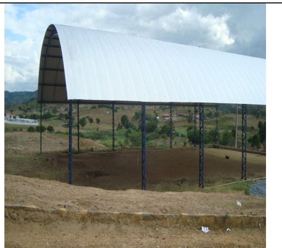
Figura 05: Construção de Ginásio no setor conhecido como “favela”. Fonte: Celetiano Fernandes, 2014.
