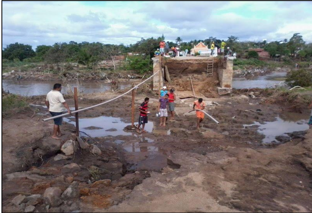
Figura 8: Enchente do riacho Curimataú em Julho de 2011.
