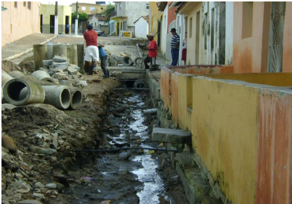
Foto 15: Colocação de galeria na Rua José Paulino. Fonte: Prefeitura Municipal, Março de 2014.
