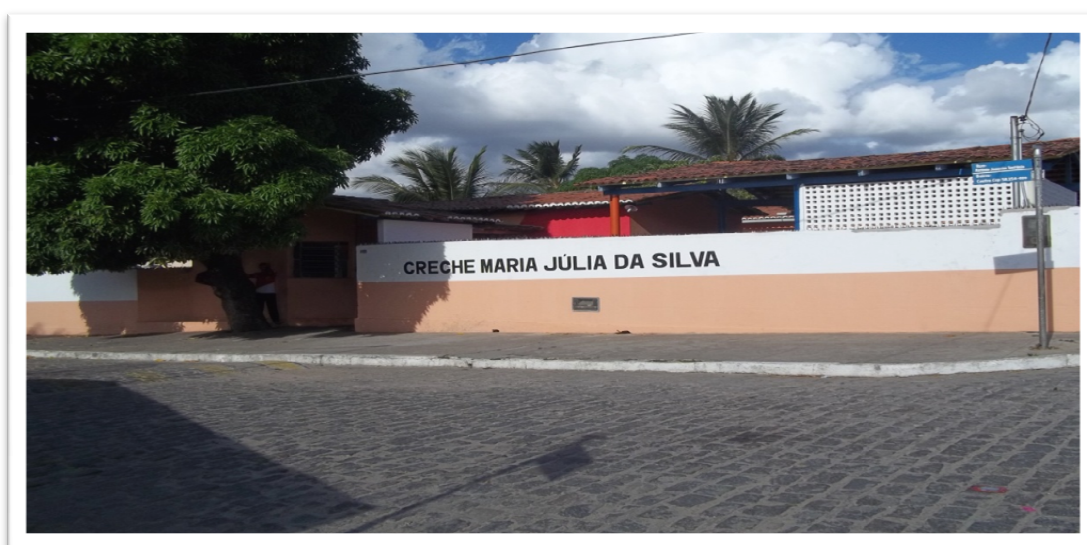
Foto 01 Estrutura da Creche Maria Júlia da Silva.
