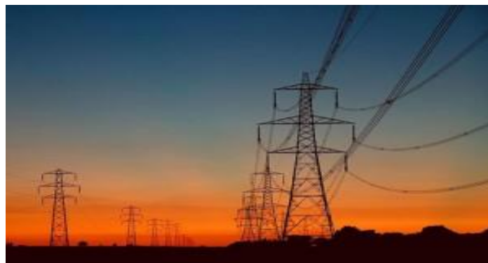
Figura 8: Redes de transmissão de energia elétrica.
