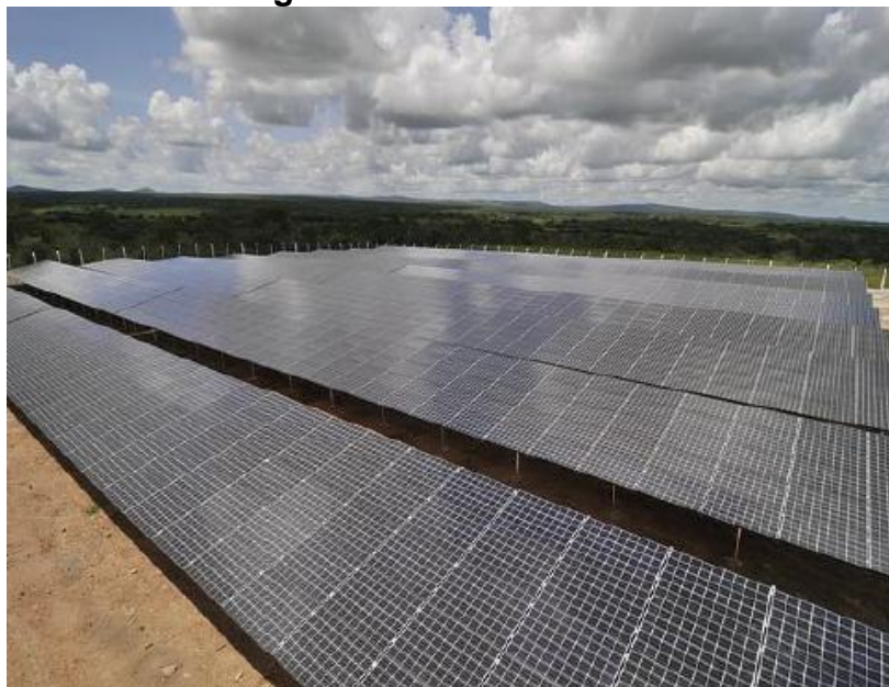
Figura 14 - Usina de Taiuá
