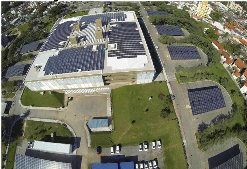
Figura 16 - Usina MEGAWATT SOLAR
