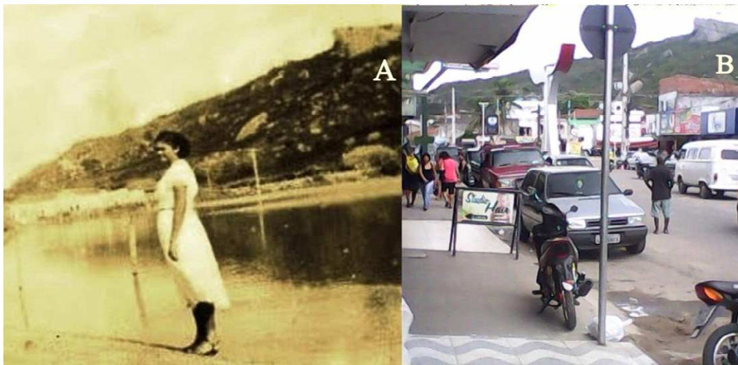
Figura 05: Centro da Cidade de Queimadas, em A ocupado por um Antigo Açude. Em B aterrado e construído.
