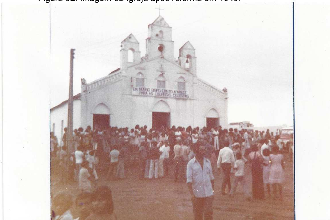
Figura 02: Imagem da Igreja após reforma em 1949.
