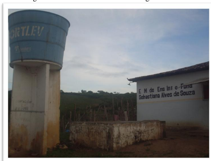
Figura 2 – Frente da Escola Caixa d'água e cisterna.
