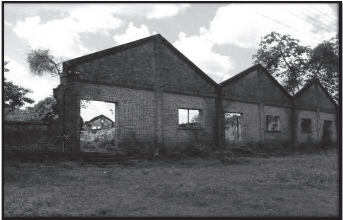
Figura 7 - Ruínas do prédio do SENAI Pesquisa bibliográfica, 2014 – imagem tirada da internet.
