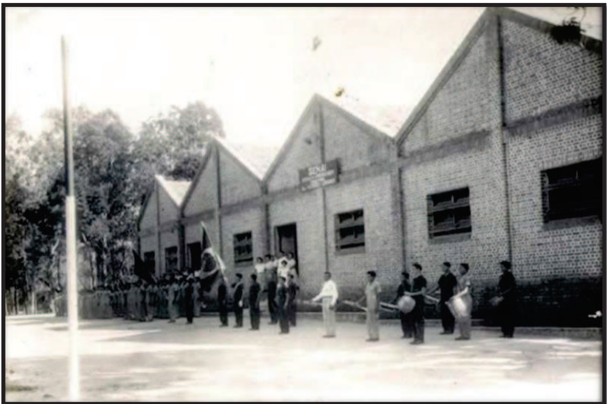
Figura 6 - Fachada do SENAI Fonte: Acervo do site – http://www.riotintopb.com.br
