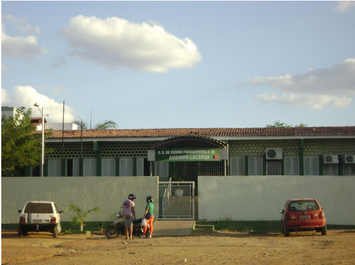
Foto 02: Vista exterior da EEEM AUZANIR LACERDA
