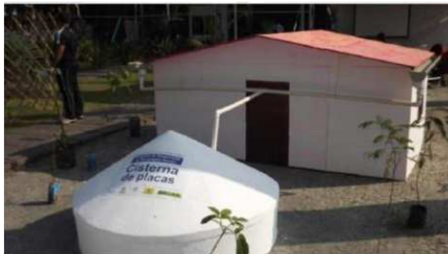
Figura 3- Sistema de captação de água Fonte: asabrazil.org.br (Acesso em 18 de maio de 2014)
