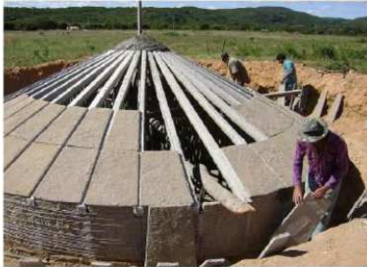
Figura-1 Construção de cisternas de placas Fonte: Articulação para o semiárido brasileiro
