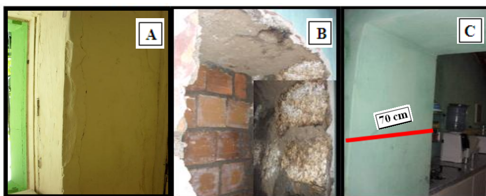
Figura 4. Edificações construídas em Adobe (A) e parcialmente em alvenaria de pedra (B e C), nas cidades de Fagundes e Pocinhos, Paraíba, NE do Brasil, 2011.
