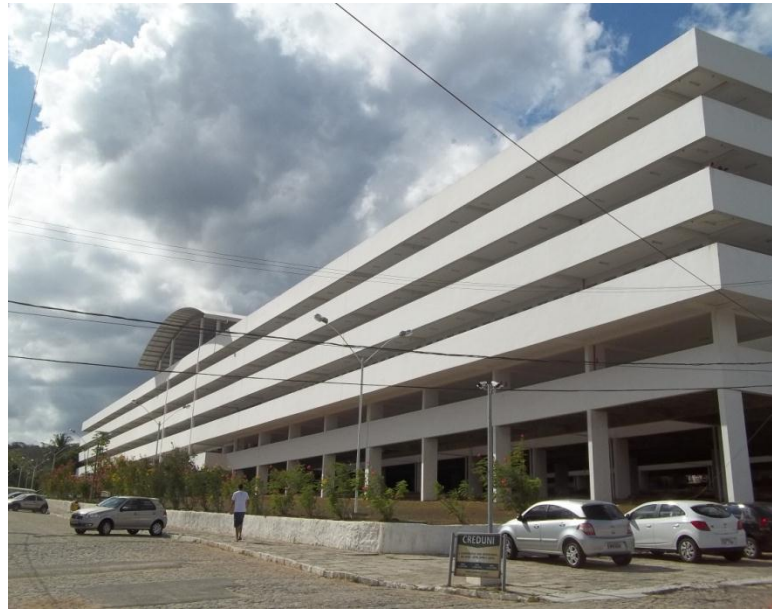
Figura 3.1 – Central Integrada de Aulas: Fachadas Sul (a) e Leste
