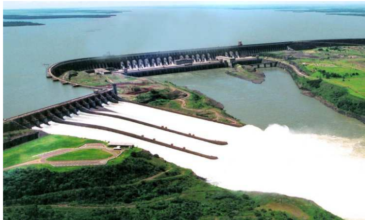
Figura 4 - Usina de Itaipu.
