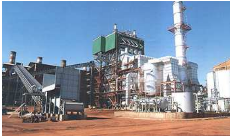
Figura 5 - Usina de biomassa no município de Manacapuru - AM.
