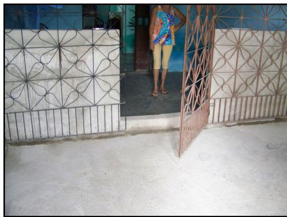
Figura 30 - Batente e calçamento altos para impedir a entrada da água dentro de casa. Foto - Apolinário, 2011.
