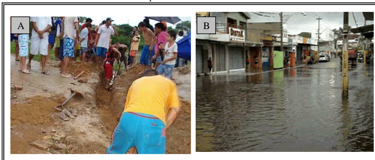
Figura 08 - Consequência da falta de rede de drenagem urbana. Foto (A): moradores abrindo valas na rua para o escoamento da água; Foto (B) Rua Antonio Gonçalves (rua comercial da cidade) em período de chuva forte
