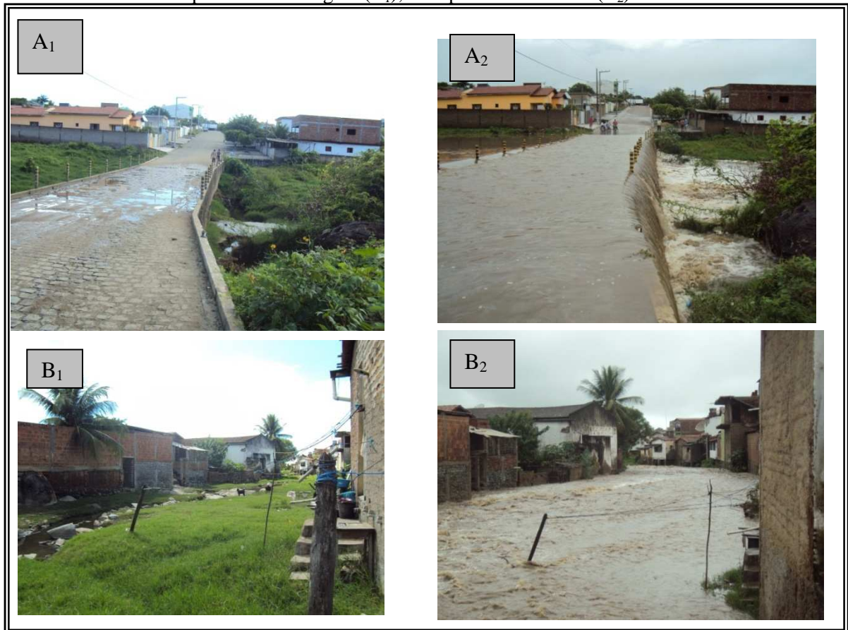
Figura 09 - Rua Manoel Siqueira Lima no período de estiagem (A 1 ) e no período de chuva (A 2 ). Rua Zé Ferino de Paula, à esquerda do riacho e Rua Manoel Barboza Monteiro à direita do riacho no período de estiagem (B 1 ), e no período de chuva (B 2 ).
