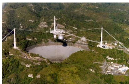
Figura I - O maior radiotelescópio do mundo, contrariamente aos telescópios convencionais, é imóvel, porém, com seu tamanho gigantesco, capta longas faixas de sinais de rádio quando fontes astronômicas emitem no local que ele está montado.
