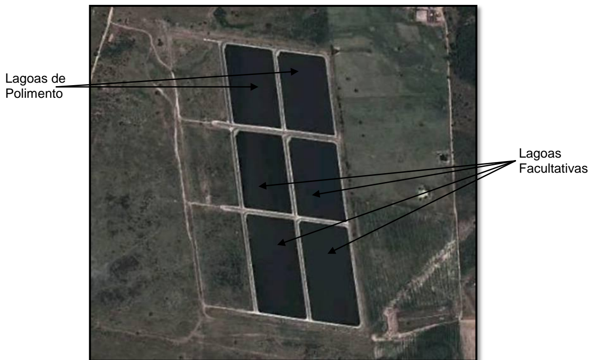
Figura 9 - Sistema De Lagoas De Estabilização Em Funcionamento.
