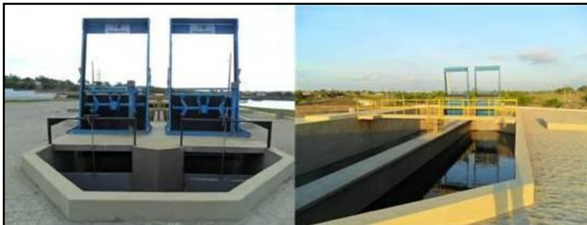
Figura 8 - Nova Caixa De Areia Com Grades Mecanizadas.
