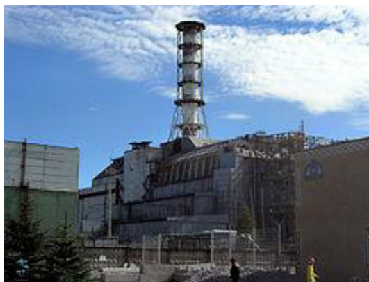
Figura 9 - O Sarcófago da Usina Nuclear de Chernobyl que abriga o reator 4, construído para conter a radiação liberada pelo acidente.
