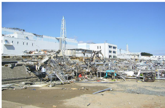
Fig. 23 – Área ao redor das unidades 1-4 III. Fonte: Fonte: http://photo.tepco.co.jp/en/date/2013/201302-e/130201-01e.html
