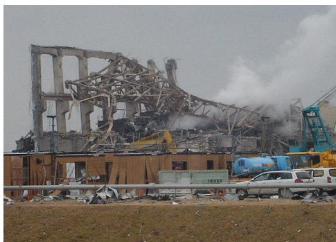
Figura 24 – Estruturas dos reatores.
