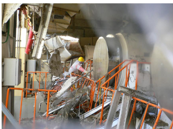
Figura 16 – Edifício de Armazenamento.
