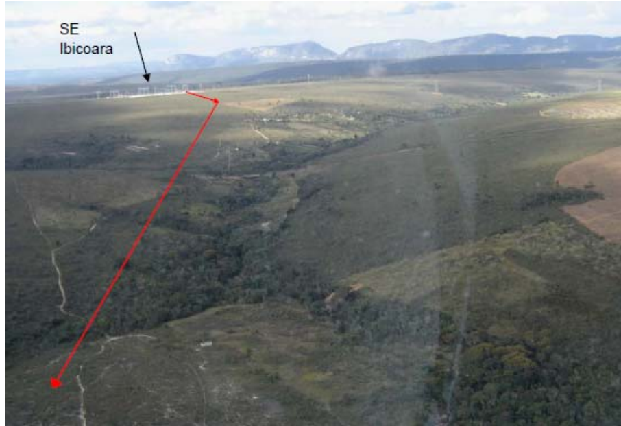
Figura 17 - Saída da subestação de Ibicoara
