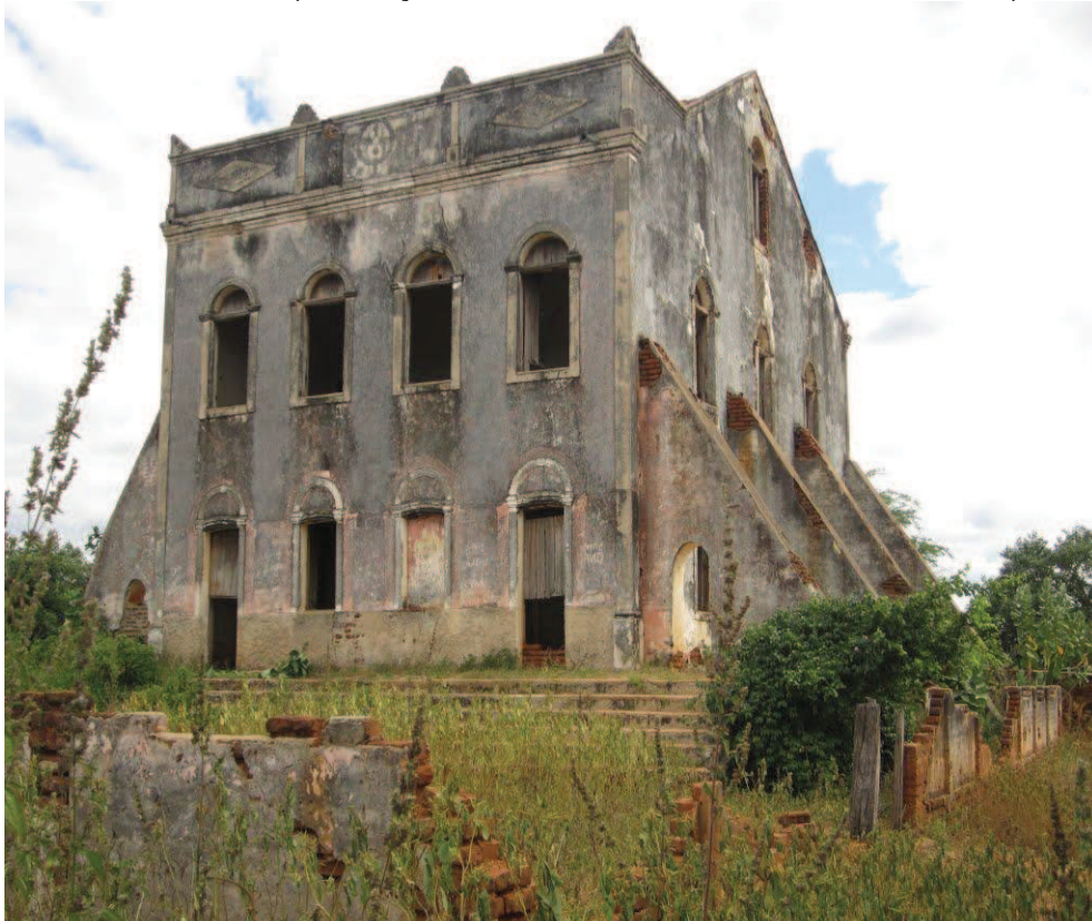
FIGURA 01: Sobrado (construção do século XIX. Primeiro edifício construído).
