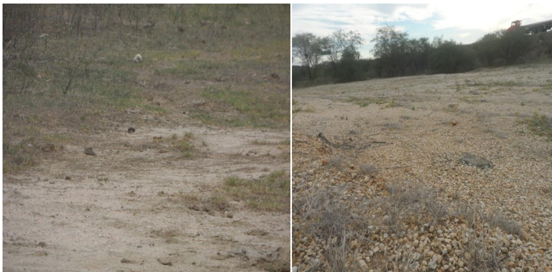
Foto 07. Erosão em Laminar – Bairro Petrópolis – Pombal-PB Fonte: (TOMAZ; NETO, 2014).
