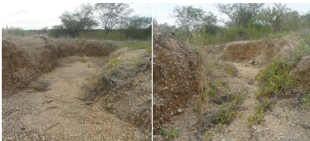
Foto 10. Erosão Voçorocas – Bairro Petrópolis – Pombal-PB Fonte: (TOMAZ; NETO, 2014).
