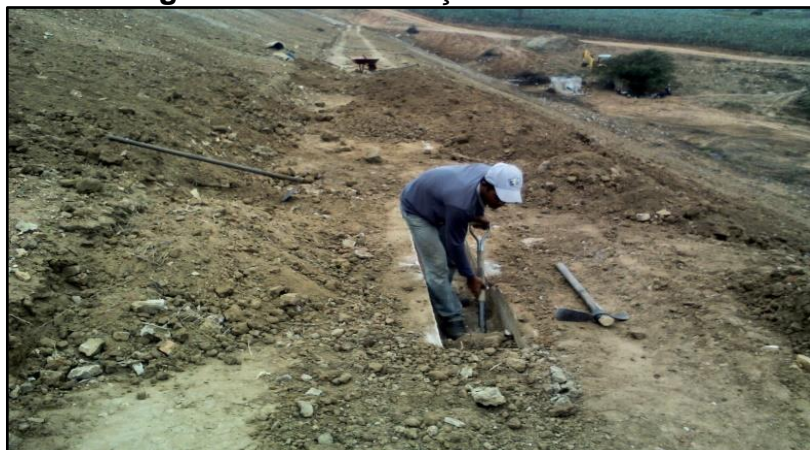
Figura 41- Desobstrução dos canaletes
