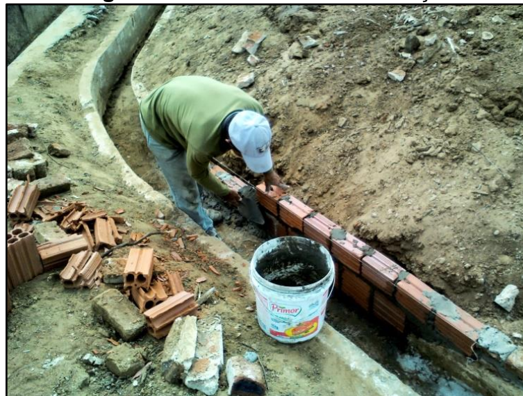
Figura 45- Canaleta em reconstrução
