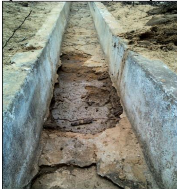
Figura 18- Canaleta com piso desgastado
