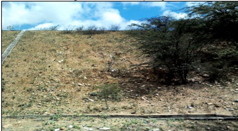
Figura 25- Talude desprotegido
