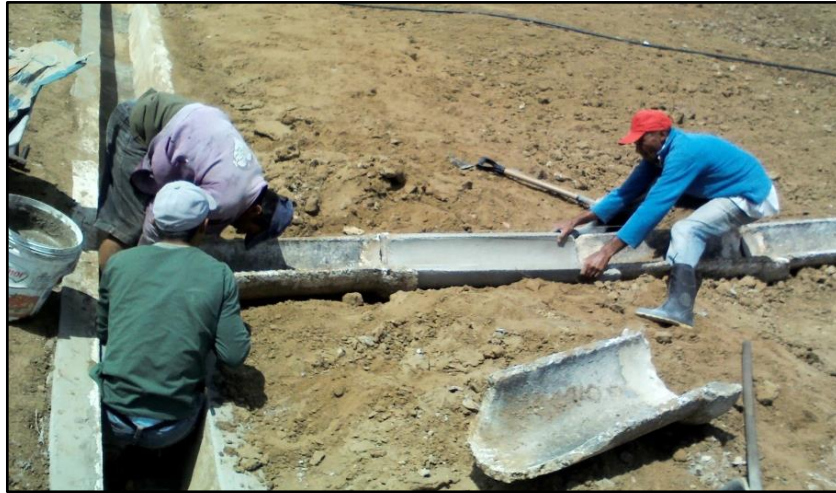
Figura 47- Substituição e reposição das canaletas
