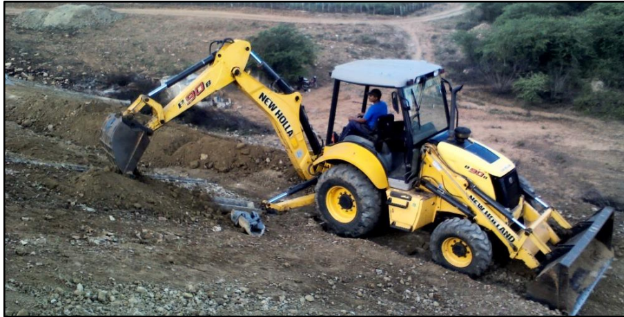
Figura 38- Retroescavadeira sobre a berma repondo material no talude
