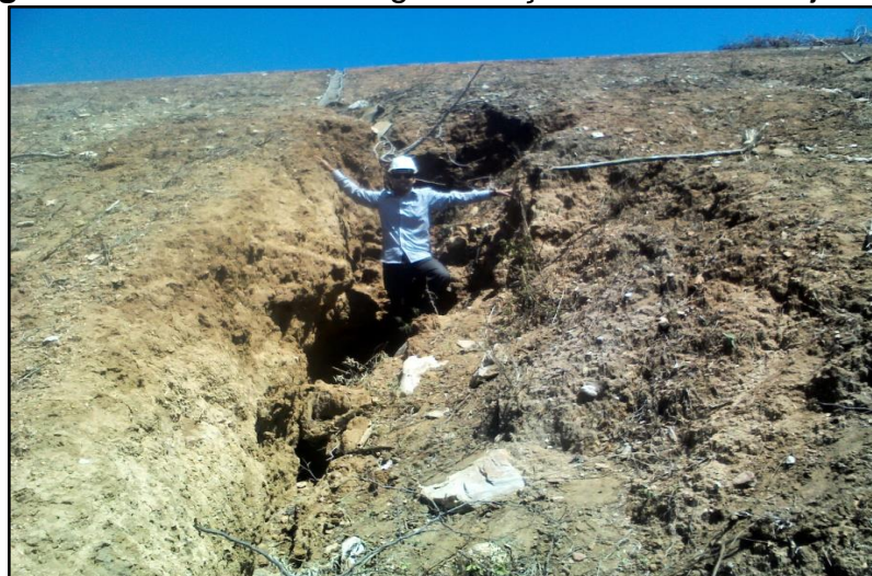
Figura 15- Erosão em estágio avançado no talude de jusante
