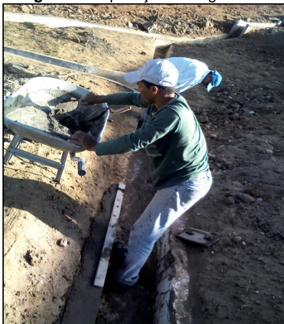
Figura 43- Aplicação de argamassa
