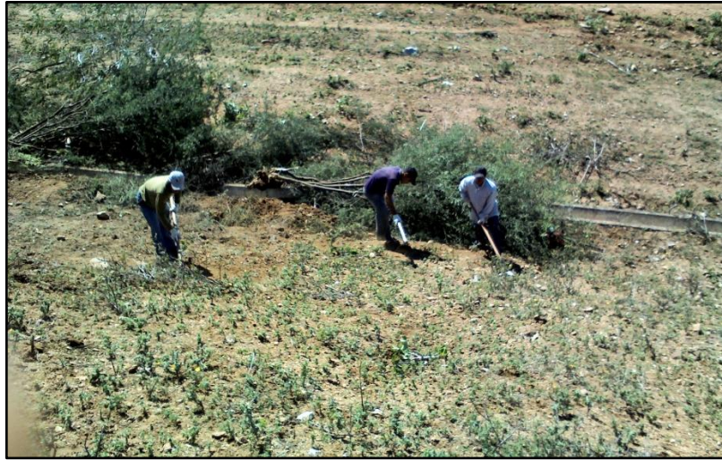
Figura 31- Limpeza da vegetação menor no talude de jusante
