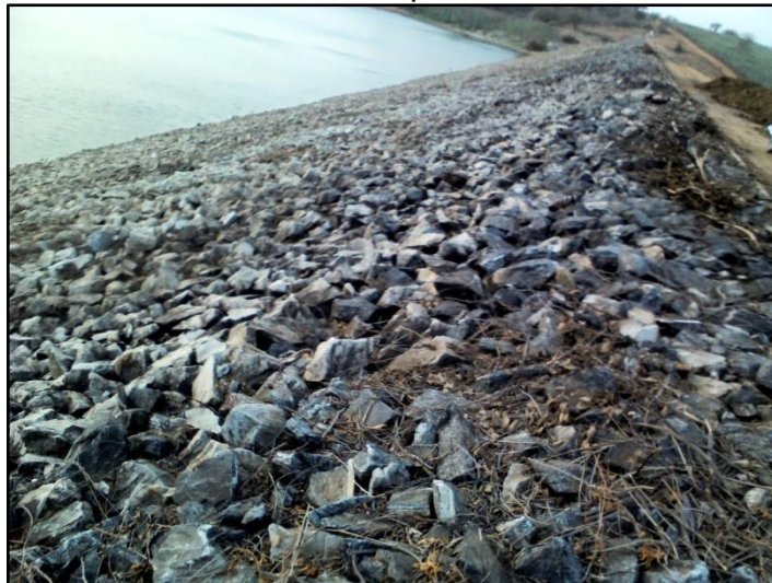
Figura 34- Talude de montante após o desmatamento e limpeza
