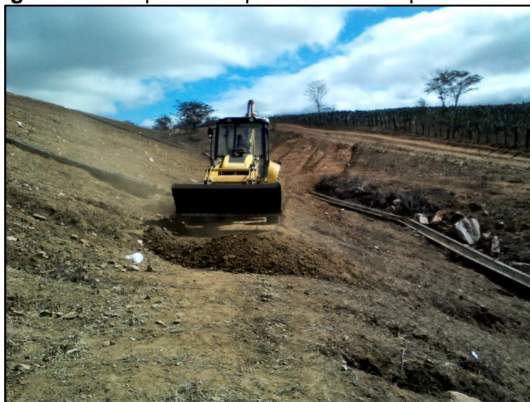
Figura 21- Máquina adequando a berma para o acesso
