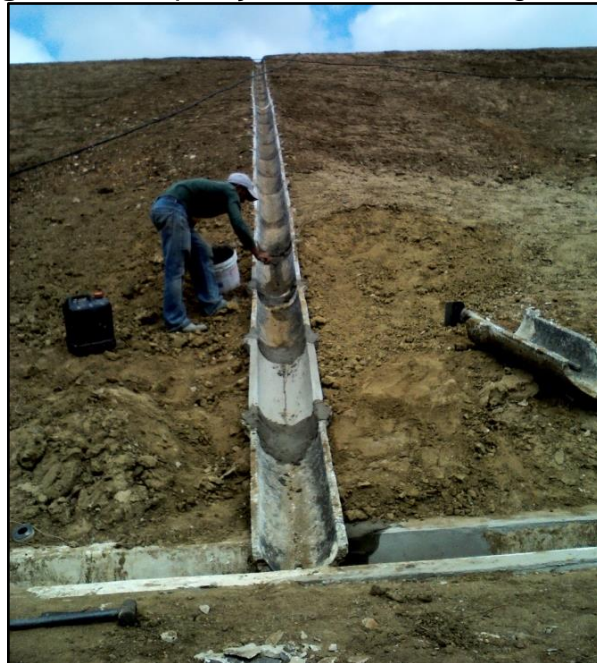
Figura 48- Reposição dos selos de argamassa
