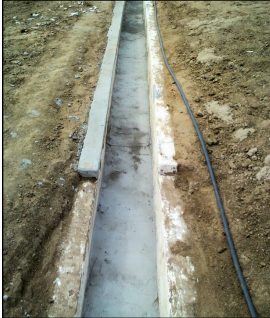
Figura 44- Canaleta com piso e revestimento recuperado
