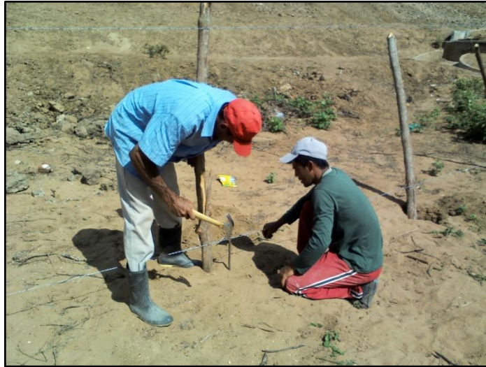
Figura 52- Construção da cerca
