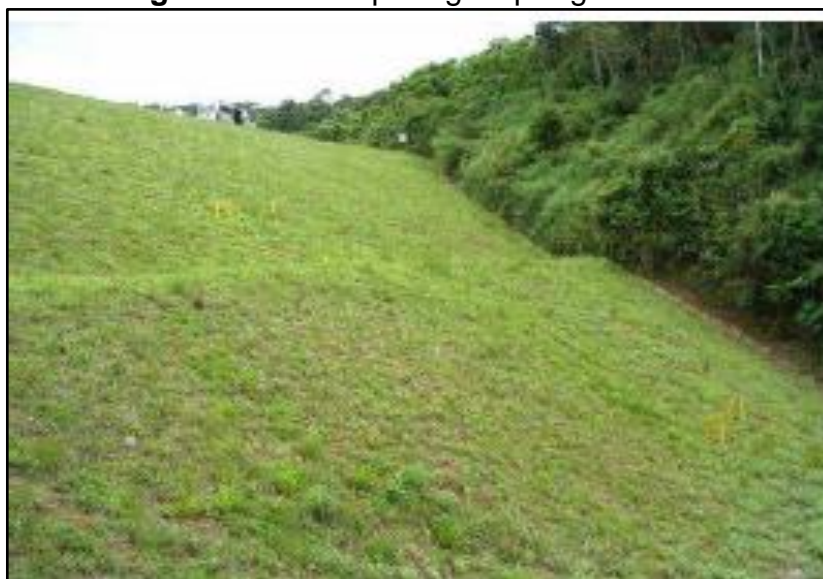
Figura 4- Talude protegido por gramíneas
