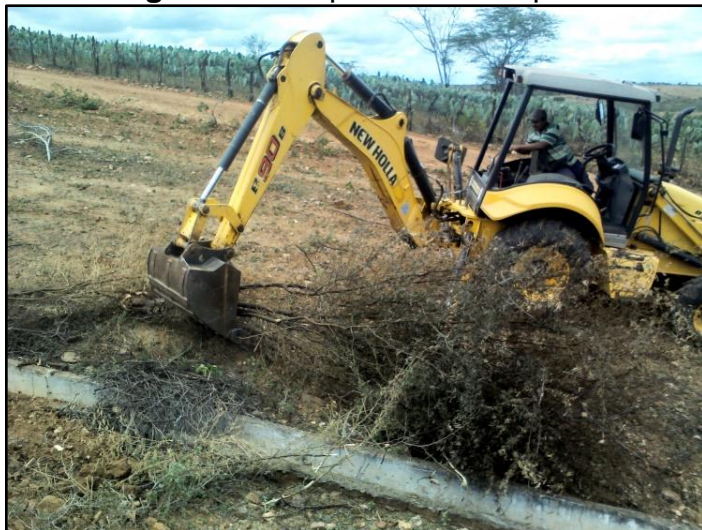
Figura 30- Limpeza com máquina
