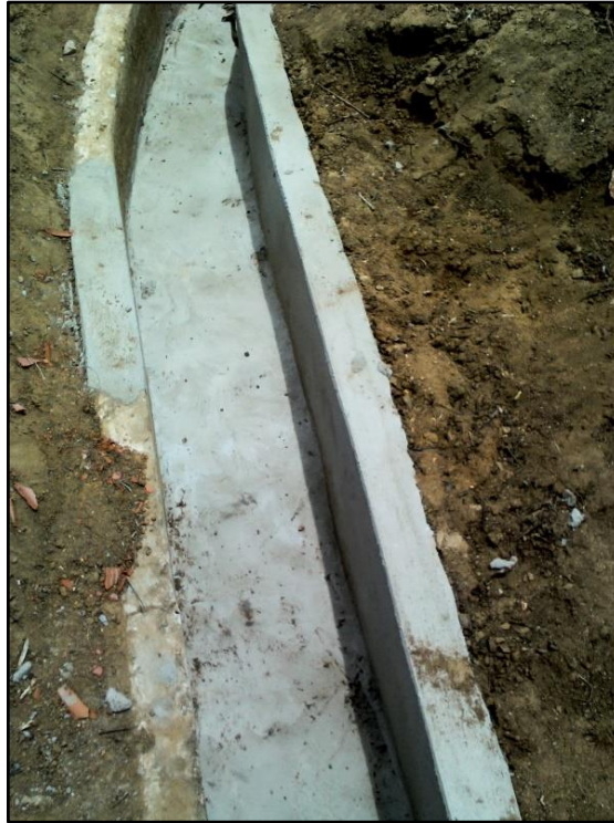
Figura 46- Canaleta reconstruído
