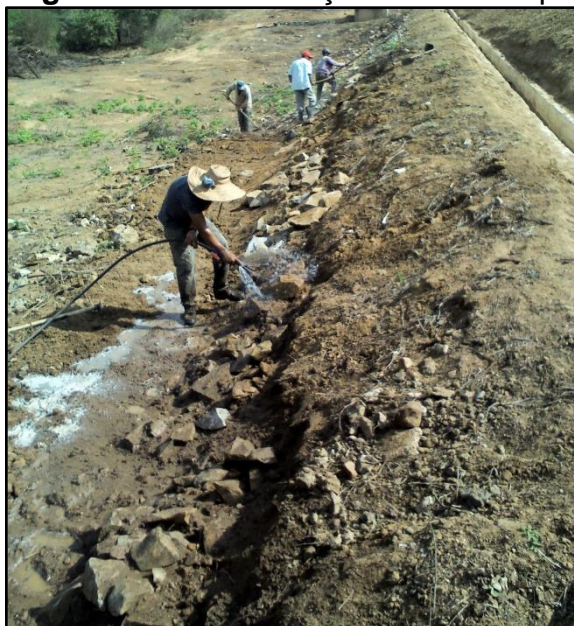
Figura 50- Desobstrução do filtro de pé
