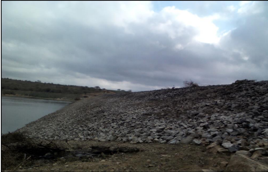
Figura 3- Talude de montante da barragem poleiros protegido por “ rip-rap ”.
