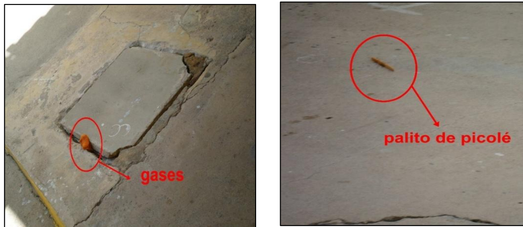
Figura 13: Resíduos em locais inadequados no HME
