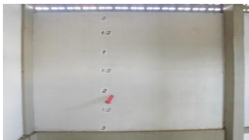
Figura 17: Verificação “artesanal” do nível do poço de sucção da estação elevatória de água de Boa Vista - PB.
