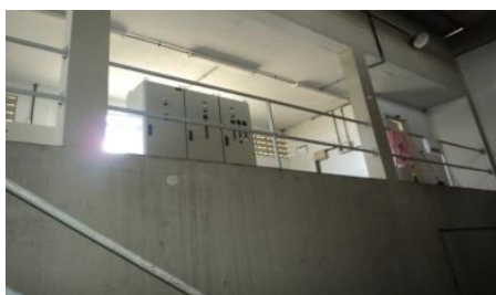
Figura 11: Corrimão de segurança da estação elevatória de água de Boa Vista – PB.
