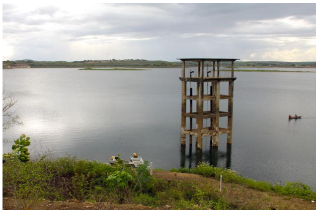
Figura 5: Torre de captação da barragem de Boqueirão-PB. Fonte: Imagens Google
