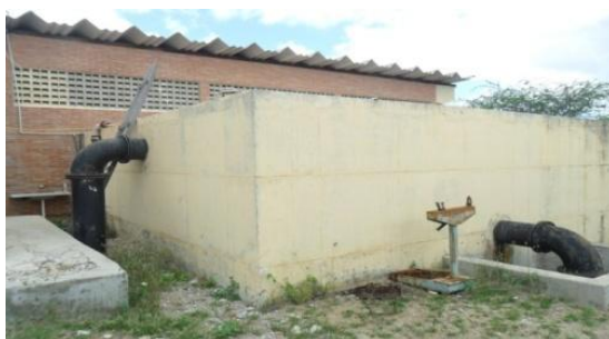
Figura 18: Reservatório (poço de sucção) da estação elevatória de água de Boa Vista – PB.
