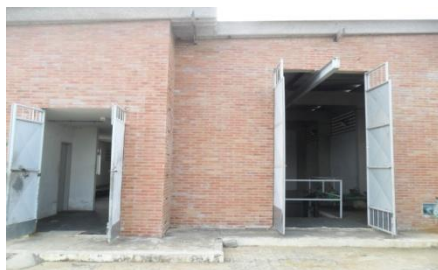
Figura 7: Portões de entrada e saída de equipamentos da estação elevatória de água de Boa Vista – PB.
