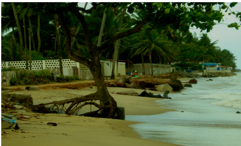
Figura 9 – Processo erosivo na praia de Pau Amarelo, com destruição da via de acesso.
