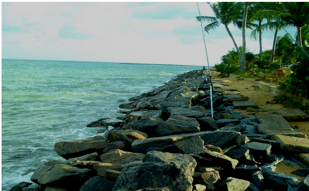
Figura 8– Linha de costa artificializada por enrocamento aderente, ao sul da praia do Janga.
