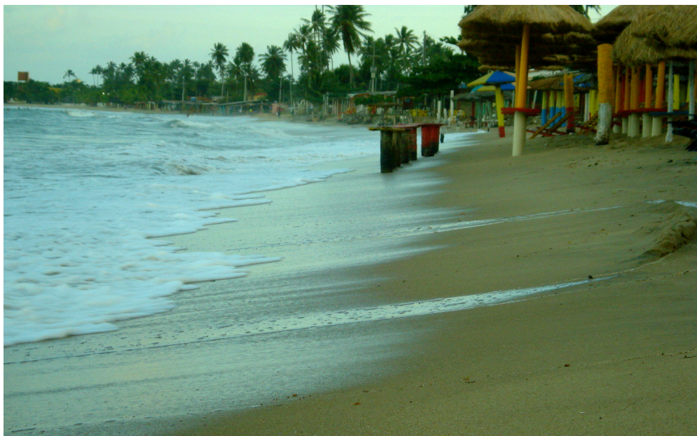
Figura 15 – Construções de bares no estirâncio da praia da Conceição.
