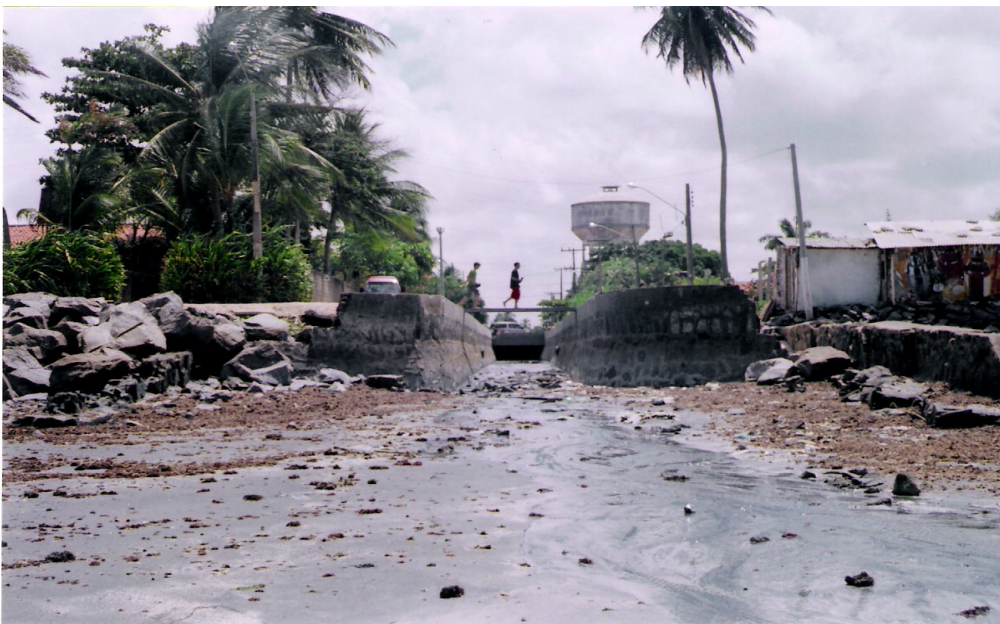
Figura 26 – Canal para escoamento pluvial e flúvio-lagunar na praia de Pau Amarelo, em 2006.
