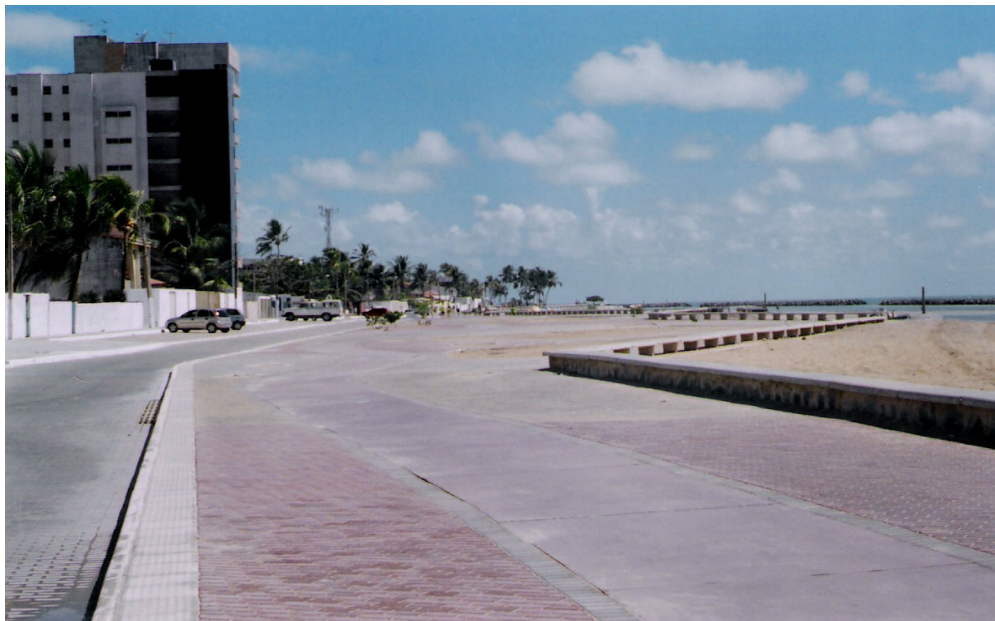
Figura 24 - Obra de intervenção urbanística na praia do Janga, em 2006.
