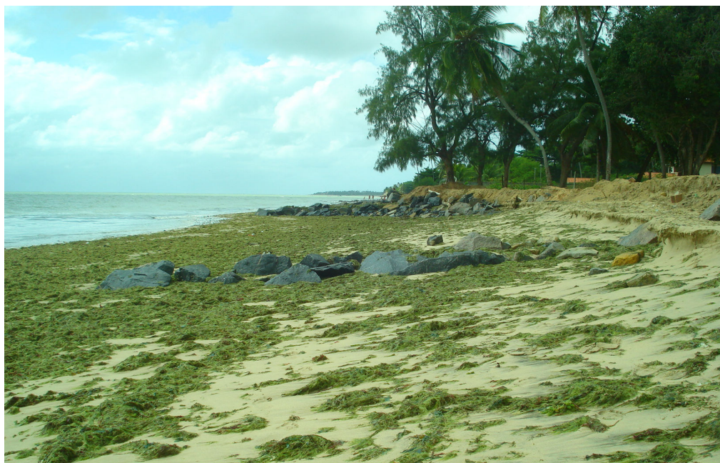
Figura 21 – Obras de contenção do avanço do mar no Pontal de Mariaia Farinha.
