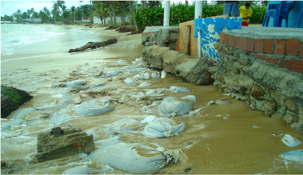
Figura 30 – Presença de sacos de areia no estirâncio do setor 2 para minimizar processos erosivos na praia de Pau Amarelo.
