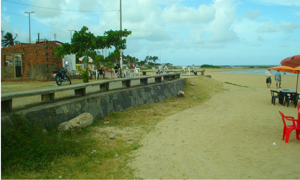
Figura 28 – Muro do calçadão da praia da Enseadinha.
