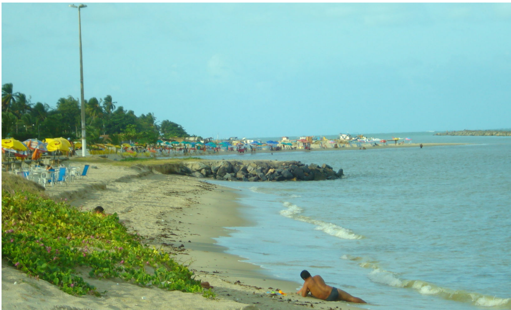
Figura 29 – Na praia do Janga a construção de enrocamento perpendicular com rochas para minimizar processos erosivos.
