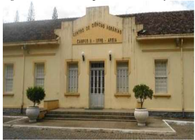
Figura 2 - Prédio CCA originários da sua fundação
