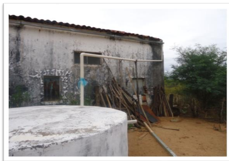
Figura 10- Condições das residências do Assentamento Nova Santana/ São José de Espinharas
