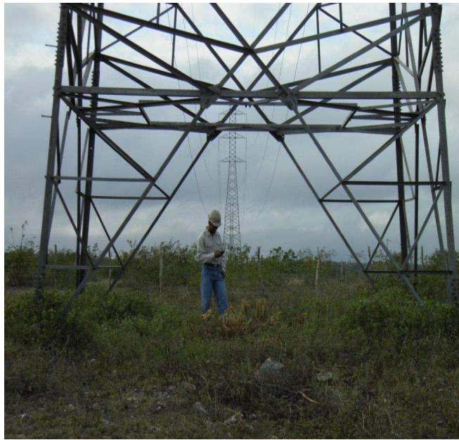
Figura 11 – Coleta de georreferência da sob a estrutura
