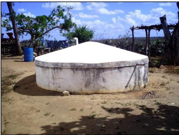
**Foto 07: Cisterna para armazenamento d'água, Sítio Lagoa da Pedra, SJC/RN**
