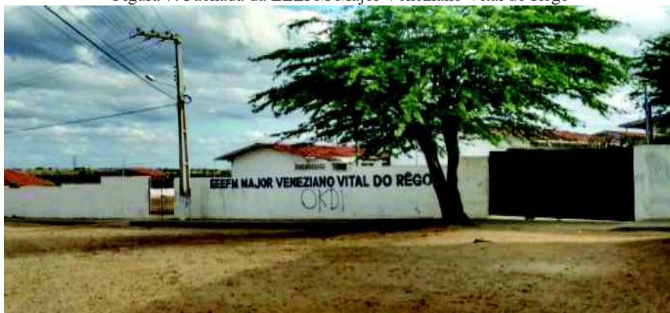
Figura 7: Fachada da EEEFM Major Veneziano Vital do Rêgo
